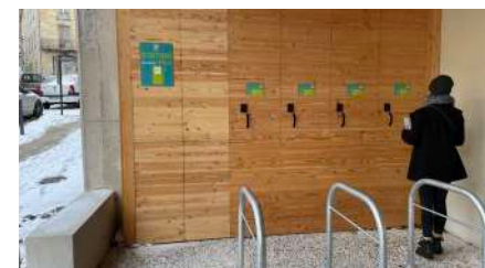
Stationnement et recharge de batterie vélo électrique
