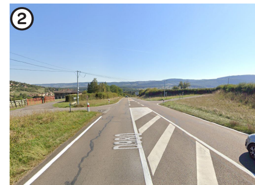
▾ Absence d'aménagement Rue La Cras
