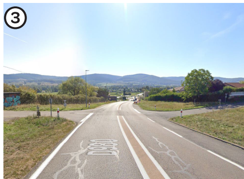
▾ Absence d'aménagement Rue Le Paradis
