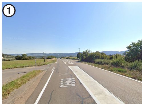
▾ Absence d'aménagement Rue La Cras
