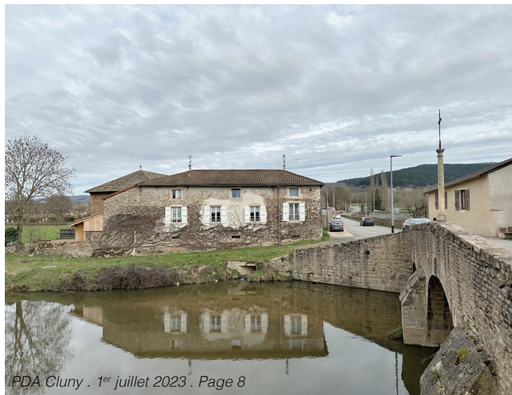
Pont sur la Grosne, D15
