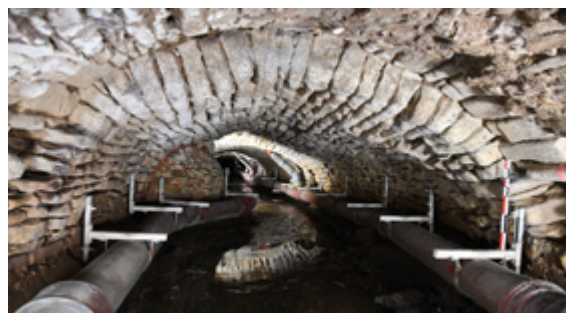
▲ Une magnifique voûte en pierre recouvre le cours du Médasson. À noter le passage des réseaux d'assainissement modernes.
