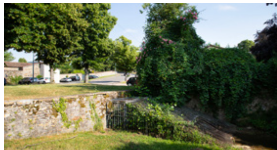
▲ Le Médasson "rentre" sous la ville au Champ de Foire. Une grille empêche l'intrusion de débris qui pourraient obstruer son cours.
